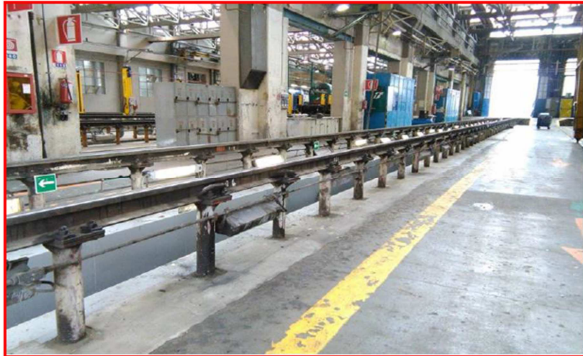
Figura 1 Binari sopraelevati su colonnine
