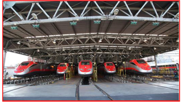
Figura 2 Binari sopraelevati su colonnine
