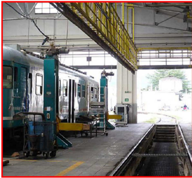
Figura 15 Fossa di verifica
