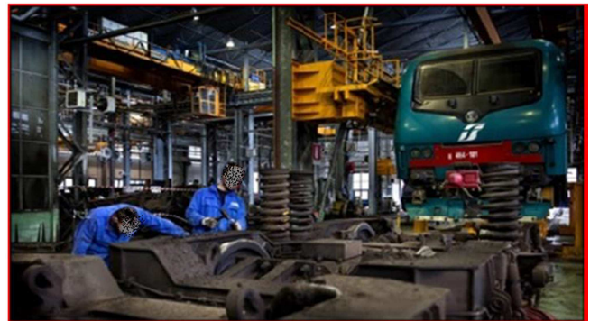
Figura 18 Altri impianti per utilizzi particolari
